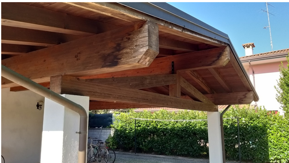
Foto n° 8 – Lotto 1 - Comune di Azzano Decimo (PN) – Foglio 19, m.le 496 sub 3. Particolare di capriata e travi della tettoia di cui alla foto precedente.
